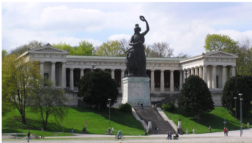
Abb. 5: Ruhmeshalle, München. Quelle: gemeinfrei.
